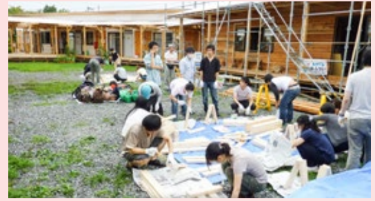
被災地での仮設住宅建設ワークショップ
