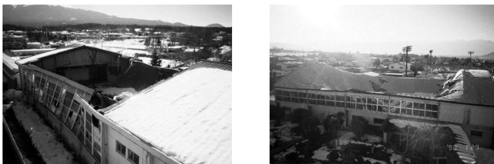
図1 想定以上の大雪で倒壊した体育館の例
