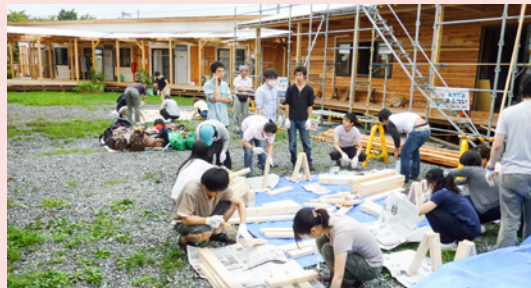
被災地での仮設住宅建設ワークショップ
