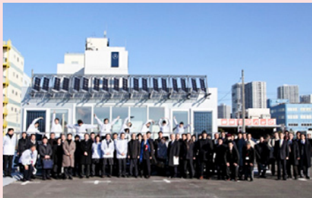
エネマネ 2014 で建設した実験住宅
